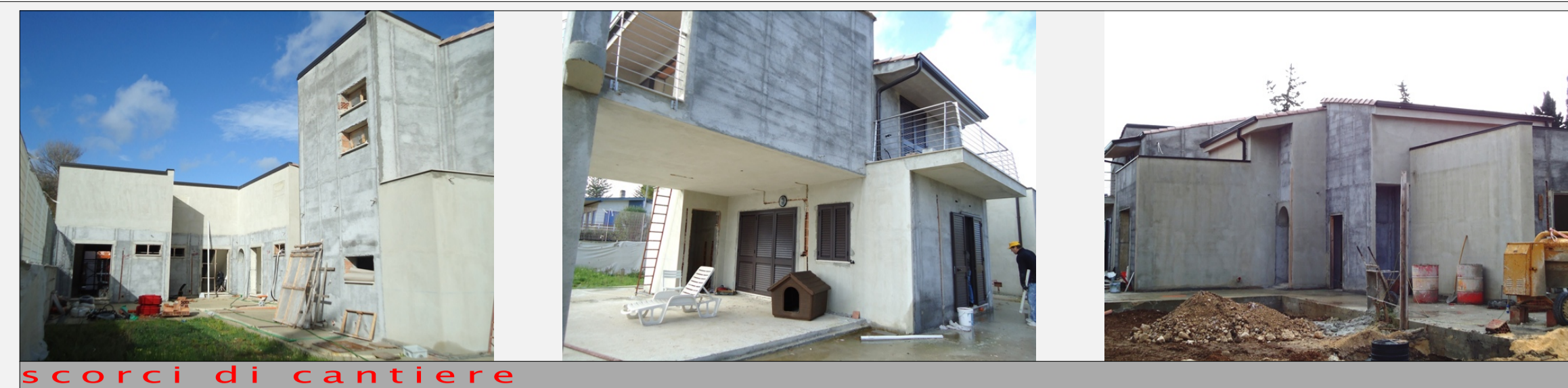
scorci di cantiere
